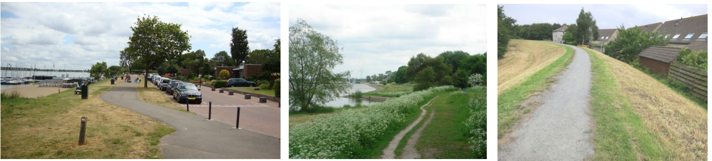
Figuur 13: De IJsselmeerdijk bij het strand van Muiden, de IJsselmeerdijk gezien vanuit het westen van Muiderberg, richting Kerk aan Zee en het Waterkeringpad op de dijk door Muiderberg.
