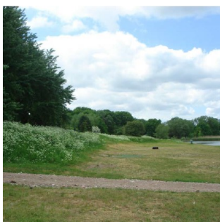
Figuur 6b: de Oude Zeedijk bij Kerk aan Zee, gezien vanuit Muiderberg.
